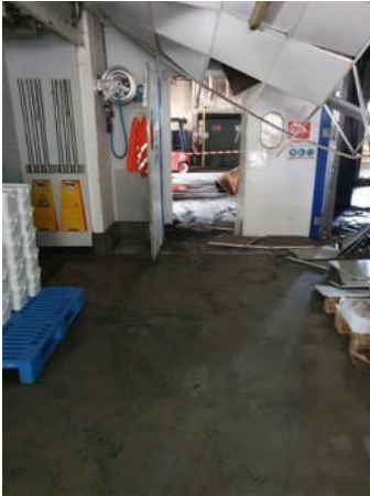
Photo n° M005 LINGETTE Localisation : Rez de chaussée LOCAL FOURAGE Ouvrage : SOL Partie d'ouvrage : LINGETTE Description : LINGETTE Localisation sur croquis : M005 LINGETTE
