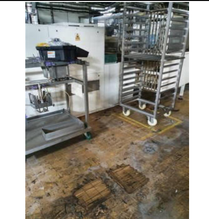
Photo n° M014 LINGETTE Localisation : 1er étage FOUR SANEG Ouvrage : SOL Partie d'ouvrage : LINGETTE Description : LINGETTE Localisation sur croquis : M014 LINGETTE
